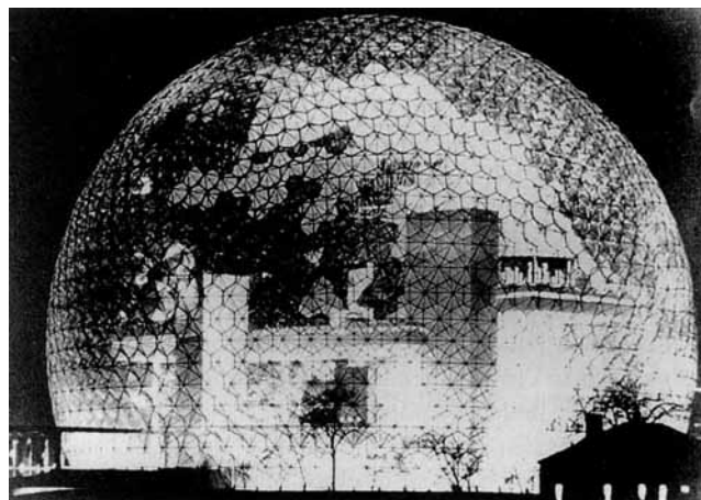
Abb. 10. Photographie der geodätischen Kuppel, die von Buckminster Fuller für die US-Ausstellungsbeiträge in Montreal zur EXPO67 entworfen wurde [75] , aufgenommen von Michel Proulx. In der Aufnahme ist eines der zum Schließen erforderlichen Fünfecke zu sehen. Die Anpassung der Strebenlänge der dem Fünfeck benachbarten Sechsecke, die notwendig ist, um eine relativ glatte runde Form zu erhalten, läßt sich ebenfalls erkennen.
